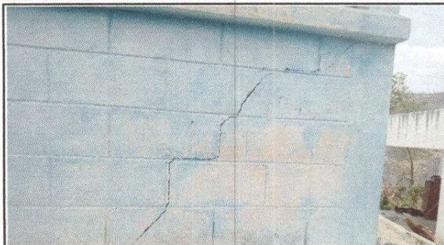
Foto 8: Reparación de muro perimetral de block
