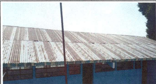
Foto 1: Sustrucción de lamina, por lámina torquelada Aluzinc calibre 26
