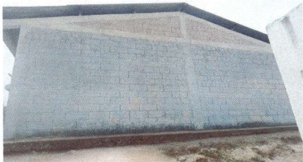
Foto 7: Pintura en muros exteriores e interiores
