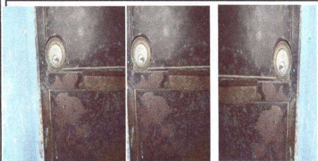
Foto 3: Sustrucción de chapa
