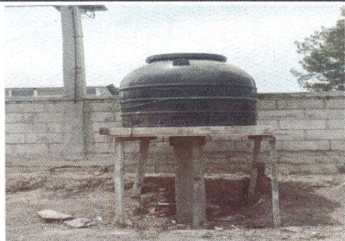
Foto 9: Sustitución de depósito de agua 750 lt
