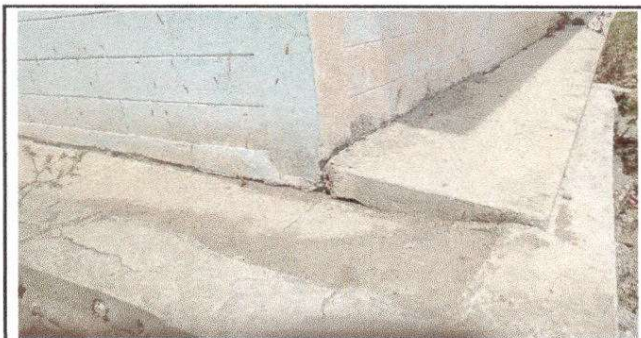
Foto 5: Sustrucción de piso de torta de concreto en banqueta
